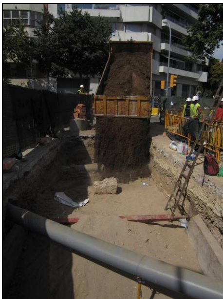
FOTO 27. Cobriment de la zona excavada en extensió, un cop finalitzats els treballs arqueològics (actuació 1), per tal de permetre a la màquina excavadora entrar-hi per aprofundir fins a la cota prevista en el projecte
