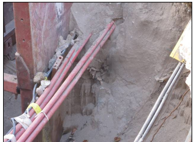
FOTO 20. Presència de fauna a la rasa de l'actuació 1 immediata a la zona excavada en extensió
