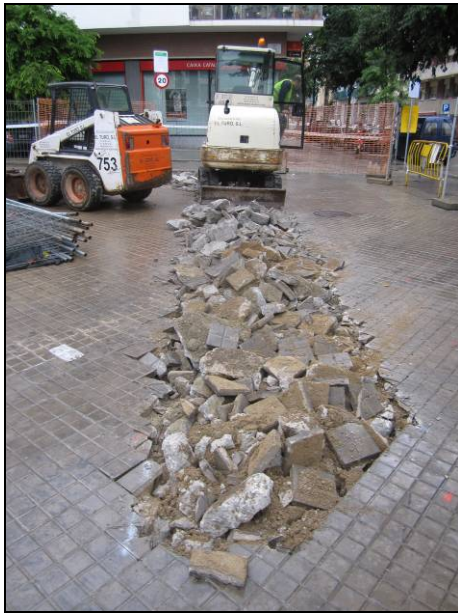
FOTO 1. Inici dels treballs d'excavació a l'actuació 1
