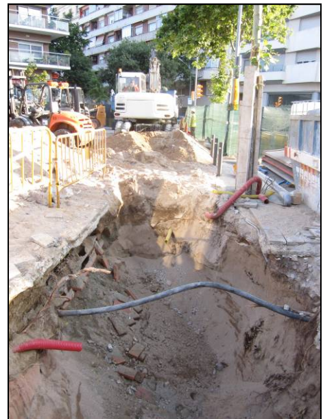
FOTO 8. Rasa per a la instal·lació de la canonada que havia de connectar amb el dipòsit de l'actuació 1 on es va dur a terme l'excavació en extensió. En aquest tram es varen detectar també restes de fauna, tot i que la perillositat dels talussos i la instal·lació de planxes de seguretat va fer impossible extreure'n més informació
