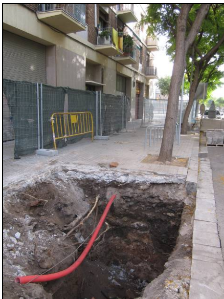
FOTO 23. Una altra vista de l'excavació per al dipòsit previst en l'actuació 3
