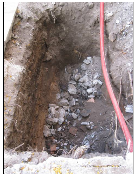
FOTO 24. Detall de l'excavació per al dipòsit de l'actuació 3
