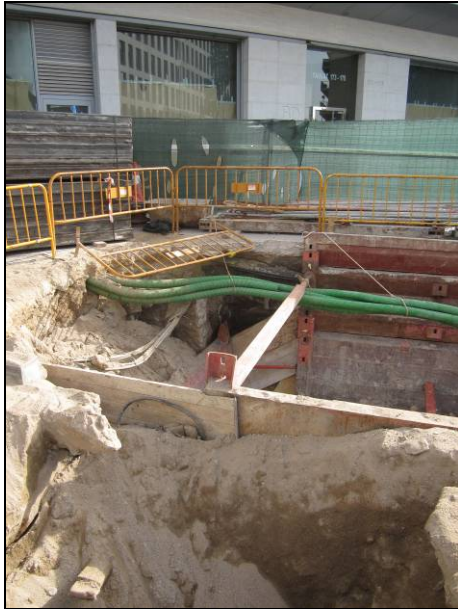
FOTO 25. Excavació per a la construcció del dipòsit previst en l'actuació número 4. No s'hi va documentar cap evidència arqueològica
