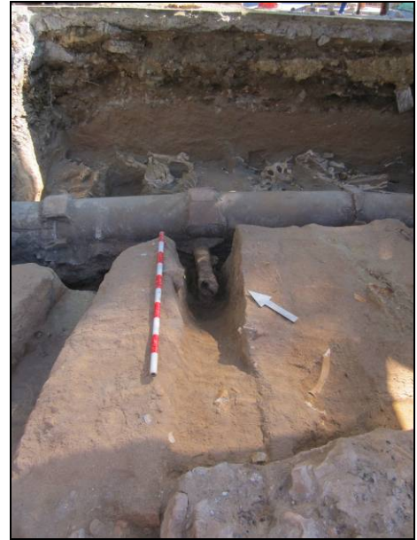
FOTO 14. Rasa UE 114 per a la instal·lació d'un tub de ferro que connectava la canonada de formigó UE 110 amb l'àrea de la fonamentació contemporània UE 113.
