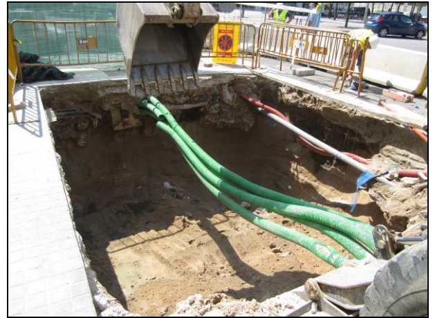
FOTO 6. Excavació per a instal·lar el dipòsit necessari per a la actuació 2. Tot i trobar-se a escassos 20 m de l'excavació en extensió duta a terme a l'actuació 1 no s'hi van detectar restes de fauna
