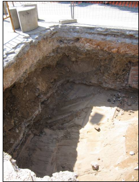
FOTO 2. Excavació per a instal·lar el dipòsit de la xarxa de recollida pneumàtica a l'actuació 1. Podem veure, en secció, el dipòsit UE 103
